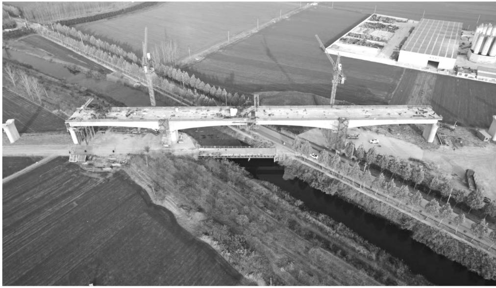
11月26日，随着最后一方混凝土浇筑入模，由中铁上海工程局承建的淮宿蚌城际铁路Ⅱ标准宿特大桥跨戚家沟、X010县道(48+80+48)米连续梁顺利合龙。这标志着该工程取得关键性进展，为后续架梁及无砟轨道施工奠定了坚实的基础。
