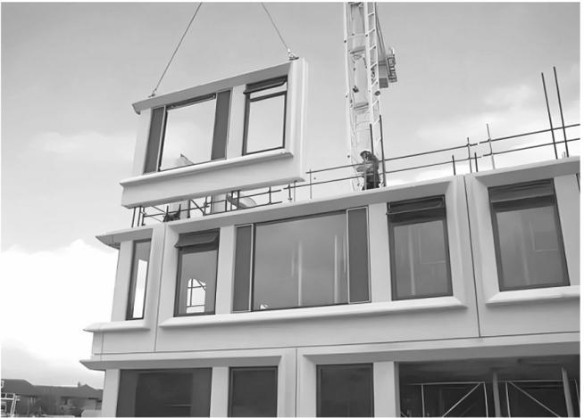
没有水泥、没有扬尘、不见焊花，随着一个个构件拼接安装，一面隔断系统就完成了。在浙江宁波北仑工业园区宿舍楼的装配式改造项目现场，工人正在进行装配式装修。“我们这个项目不仅施工迅速、噪音低，且极大减少了建筑垃圾。”
