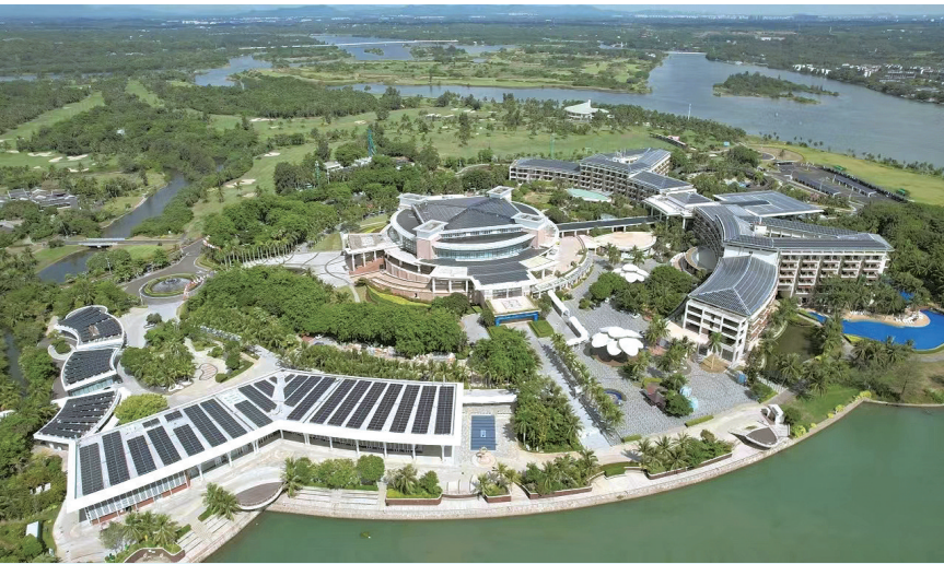
图为博鳌近零碳示范区内的博鳌亚洲论坛国际会议中心和博鳌亚洲论坛大酒店的屋顶铺满了光伏板。
