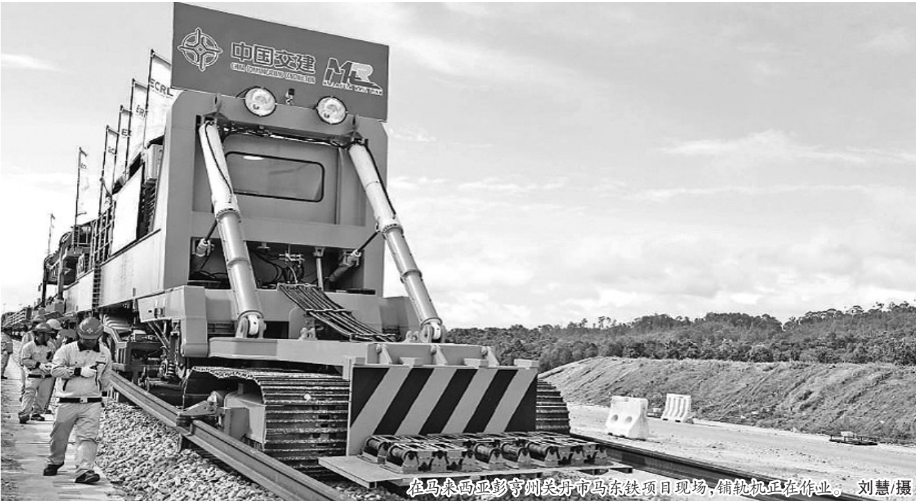
在马来西亚彭亨州关丹市马东铁项目现场,铺轨机正在作业。 刘慧/摄
