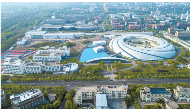
上海同步辐射光源工程
