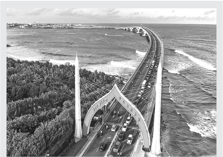
由中交二航局实施的援马尔代夫中马友谊大桥后续维保技术援助项目日前正式开工。该项目工期36个月，将对大桥进行初次修复及预防性养护等。
