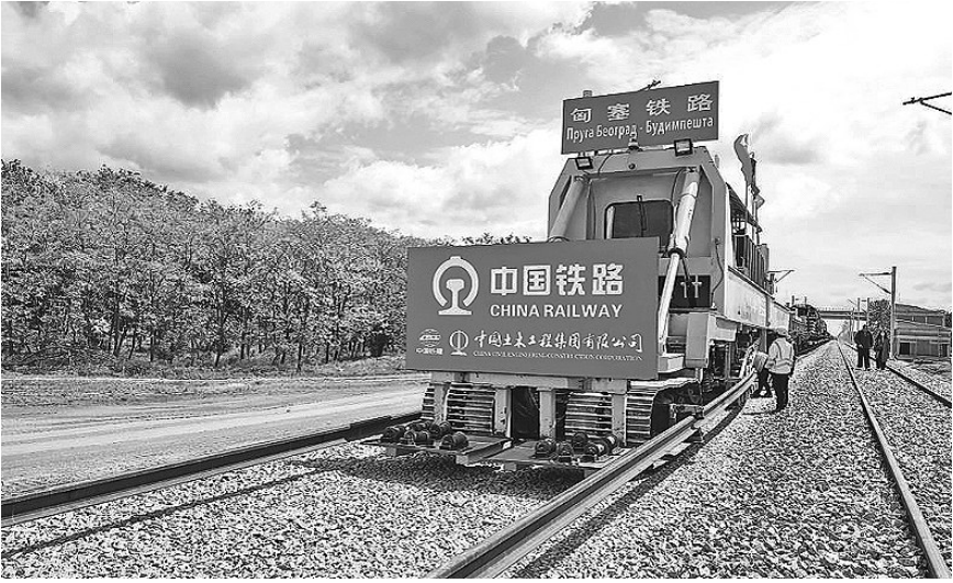
近日，在塞尔维亚和匈牙利边境地区的塞尔维亚一侧，匈塞铁路项目施工人员利用铺轨车等中国设备进行铺轨作业。
