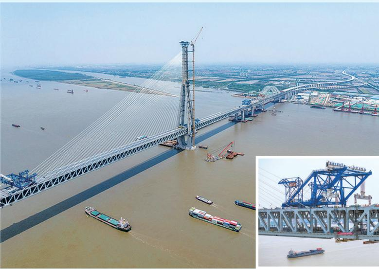
6月9日，常泰长江大桥主航道桥钢桁梁合龙段焊接对接完成，以“毫米级”精度顺利合龙，合龙精度控制在2毫米以内。至此这座世界最大跨度斜拉桥，历时5年建设实现全线贯通，长江南北两岸的常州和泰州两市成功江上“牵手”。
