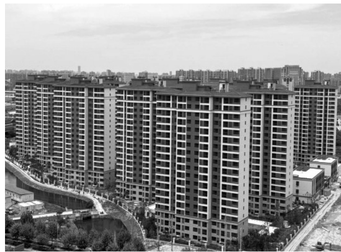
近日,由上海宝冶承建的嘉定江桥安置房项目通过上海市建设工程白玉兰奖(市优质工程)评审。
