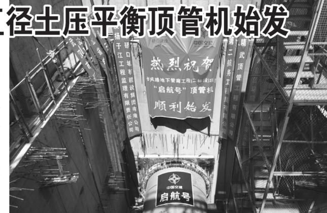
华中首台超长距离大直径土压平衡顶管机始发。图中展示了顶管机在地下管廊项目中的始发过程,背景有“启航号”顶管机的标识。
