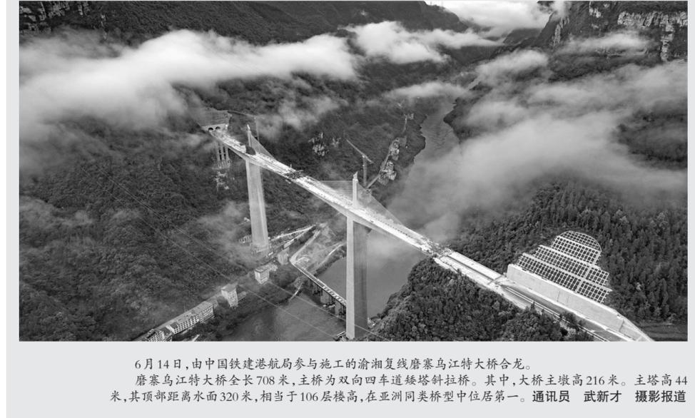
6月14日,由中国铁建港航局参与施工的渝湘复线唐寨乌江特大桥合龙。唐寨乌江特大桥全长708米,主桥为双向四车道矮塔斜拉桥。其中,大桥主墩高216米。主塔高44米,其顶部距离水面320米,相当于106层楼高,在亚洲同类桥型中位居第一。通讯员 武新才 摄影报道
