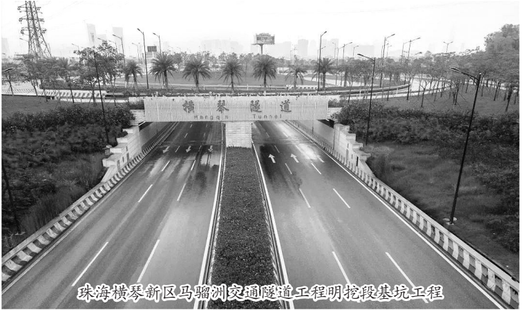
珠海横琴新区马骝洲交通隧道工程明挖段基坑工程
