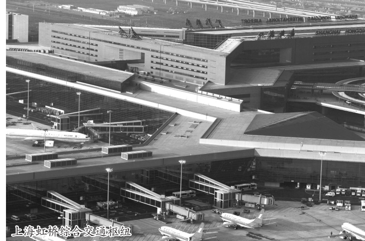
上海虹桥综合交通枢纽
