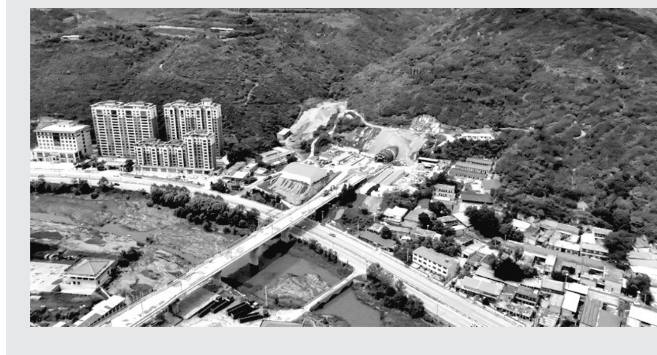
7月30日,由中铁五局承建的西延高铁太康隧道贯通。太康隧道位于陕西省延安市黄陵县,全长约13.6公里,是西延高铁全线重难点工程、控制性工程之一。西延高铁是陕北革命老区首条高铁,线路全长约299公里。建成投入运营后,西安至延安的运行时间将从目前的两个半小时缩短至一个小时左右。
