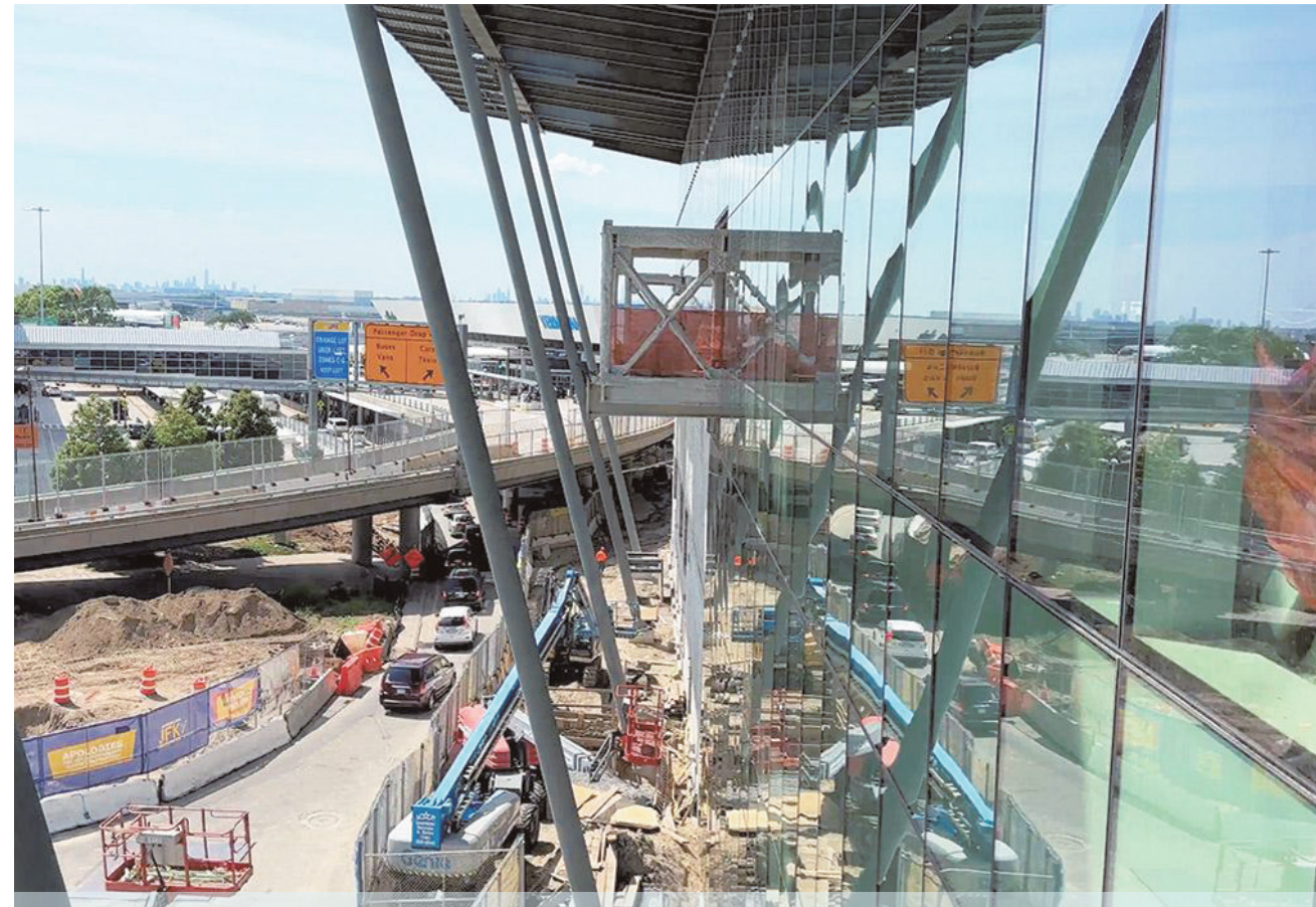
完工后,新的6号航站楼将无缝衔接到5号航站楼。
