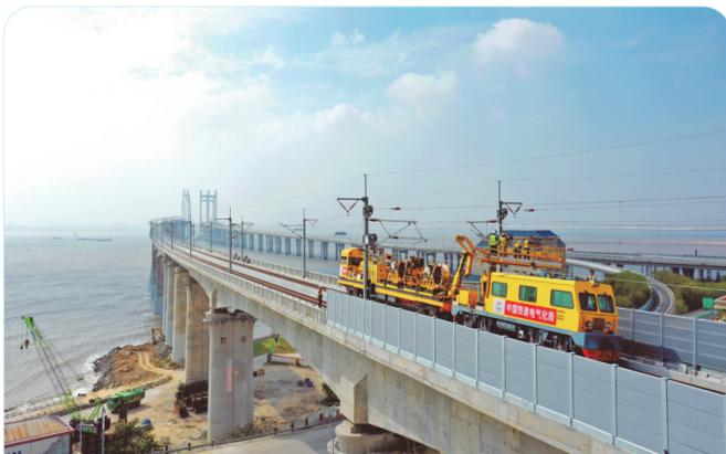
在福建泉州湾大桥工地现场，中建电电气化局集团四公司项目部员工在恒张力放线车上架设接触线。
