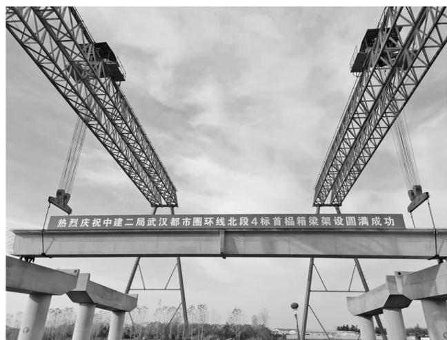
12月6日，湖北武汉六环线北段全线首榀预制预应力箱梁成功架设，标志着中建二局华中公司武汉都市圈环线北段4标项目桥梁工程正式步入上部结构施工阶段。
