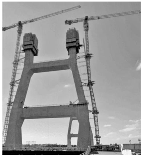
近日，中建三局旗下中国建筑先进技术研究院自主研发的全球首台“可变角度斜附式塔机”在中建三局二公司承建的莆田联十一线三江口特大桥项目首次实现变角度作业，标志着该企业在智能建造装备领域再次取得重大突破。
