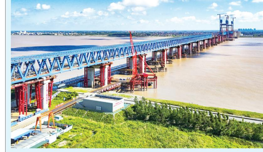
近日，由中铁大桥局承建的沪渝蓉高铁V标崇启公铁长江大桥非通航孔桥第十一轮钢梁112米精准顶推到位。目前钢梁累计顶推长度达到1064米，总重量3.15万吨。据悉，崇启公铁长江大桥非通航孔共有11个桥墩，顶推长度为1205.4米。该桥公路共需预制1872片桥面板，其中主通航孔公路桥面板672块，非通航孔公路桥面板1044块，南引桥公路桥面板156块。钢梁在工厂施工，通过水上运输船运到大桥南岸预拼装进行吊装组拼，再分13个轮次(其中9个轮次为112米)向主通航孔方向顶推。本轮顶推距离长、流程多，精度控制严。崇启公铁长江大桥非通航钢梁顶推还剩最后两轮，计划在10月底与主通航孔桥在主桥1号墩与主通航孔3号墩钢梁成功对接，其顶推长度与重量将创国内桥梁建设又一个新纪录。新建上海至南京至合肥高铁是沪渝蓉高铁的东段线路、国家“八纵八横”高速铁路网沿江高铁通道的控制性工程。崇启公铁长江大桥全长4.09公里，横跨长江入海口北支航道。大桥主通航孔桥为主跨400米的双塔双索面钢桁结合梁斜拉桥，是世界最大跨度无砟轨道公铁两用斜拉桥。(通讯员 崔永兴 王世琪 孟庆虎)
