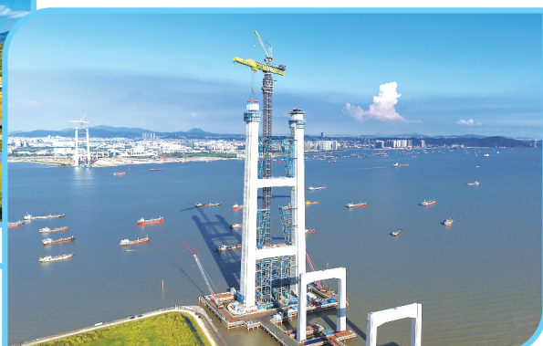
图为狮子洋大桥西主塔塔身高度突破200米
