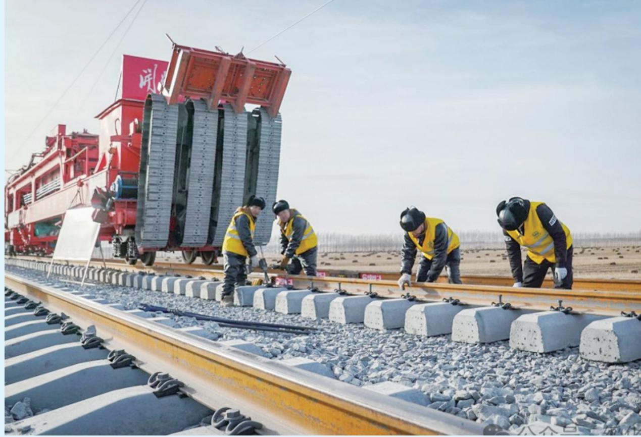
本报讯 11月25日，在位于黑龙江省绥化市庆安县的哈伊高铁铺轨现场，四名工人手持电动扳手，将最后一对钢轨螺栓拧紧，标志着我国“十四五”重点工程哈伊高铁全线铺轨贯通，为后续联调联试奠定基础。
