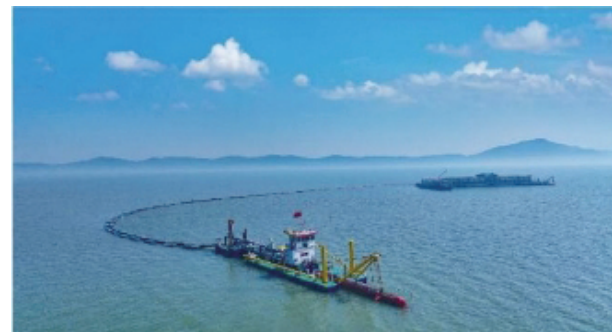
▲实施中的太湖生态清淤工程
