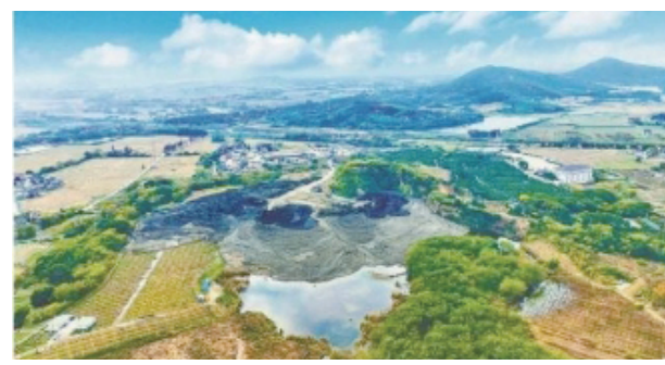
▲施工中的宜兴市废弃矿坑排泥场
