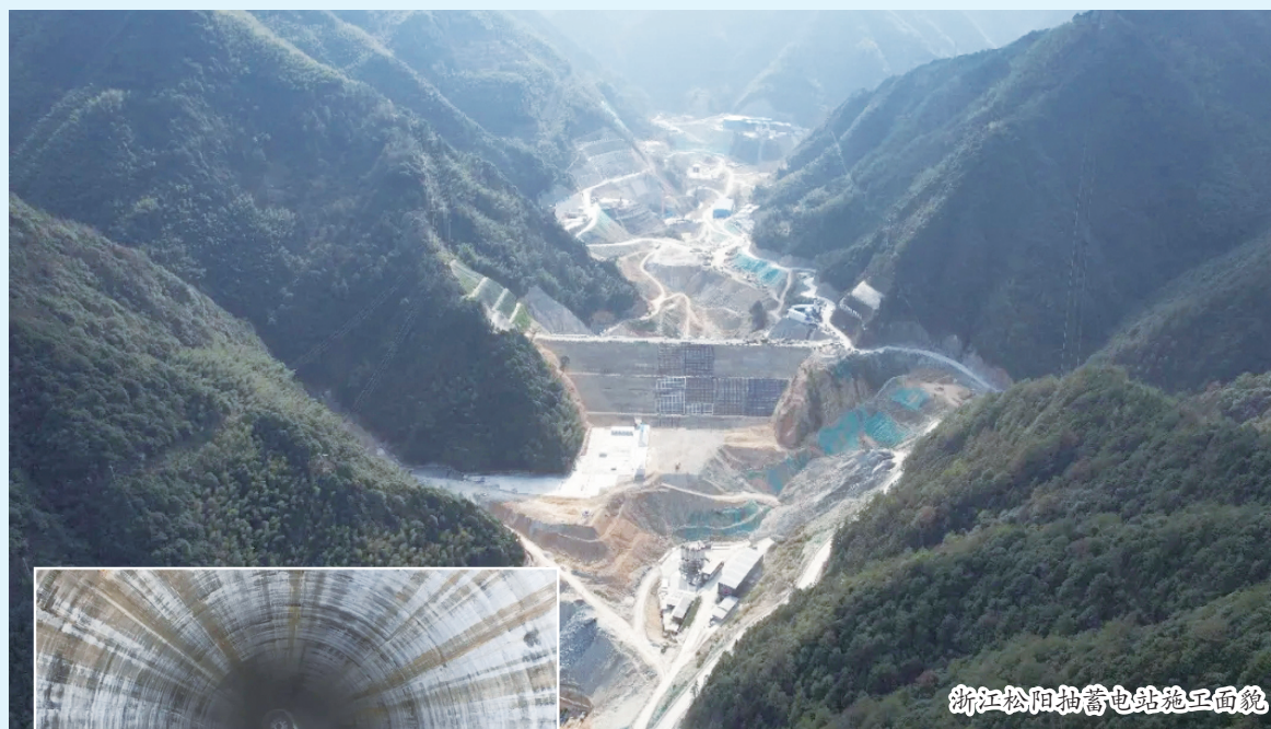
通过应用“天工号”松阳抽水蓄能电站两条深637米的竖井贯通
