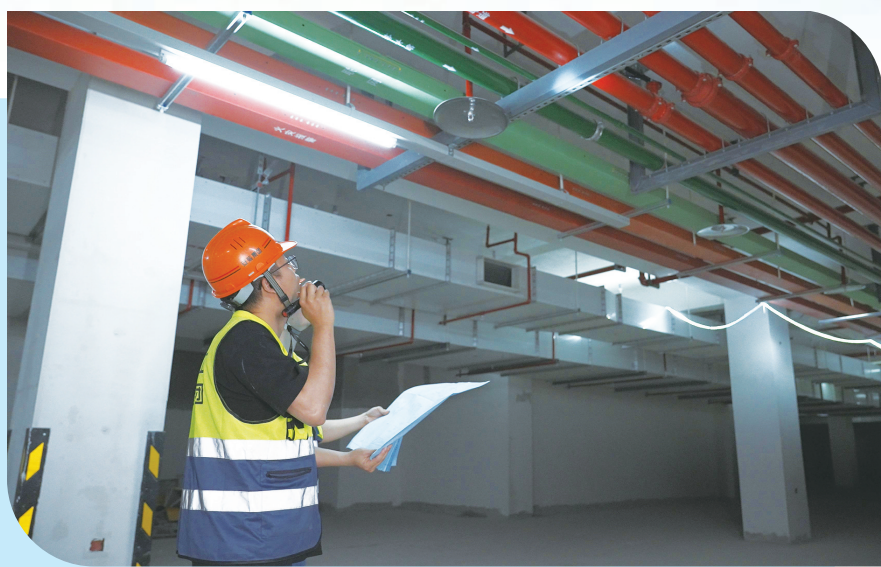
项目人员在观察地下室管架
